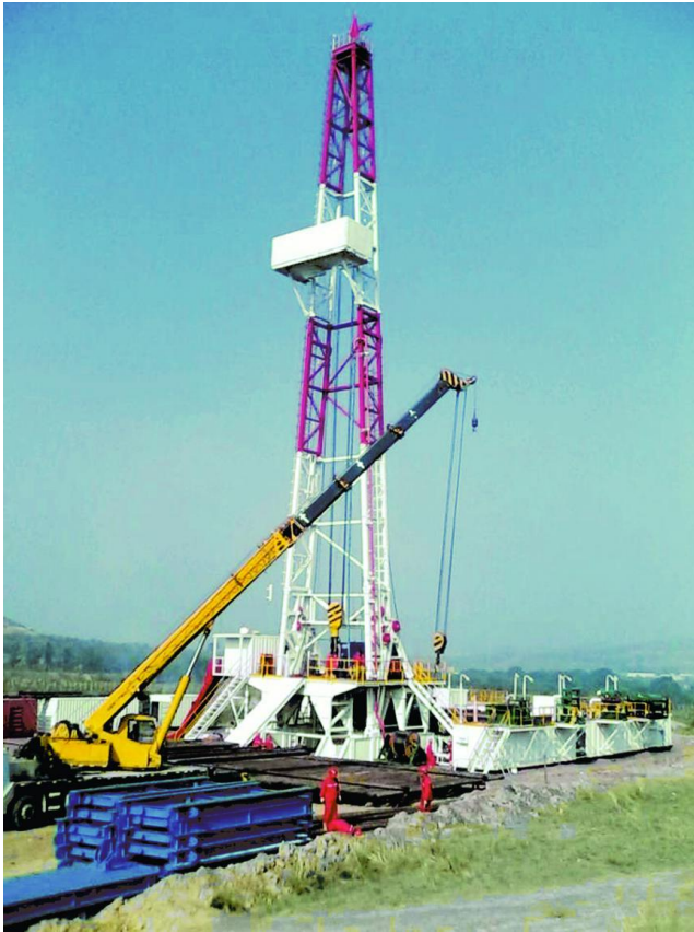
地热井施工（缺原图）
