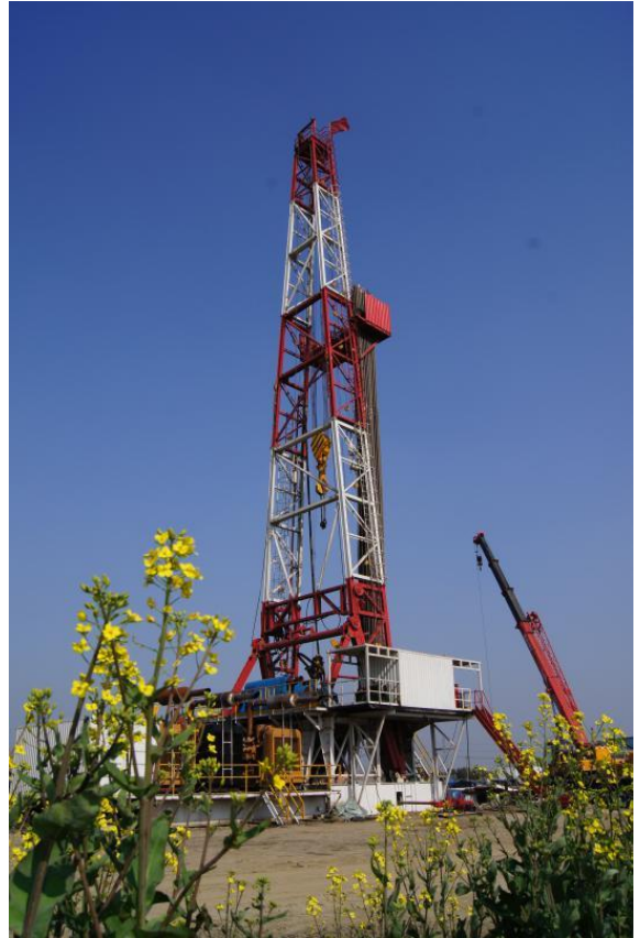
泰兴 CO 2 勘查（缺原图）
