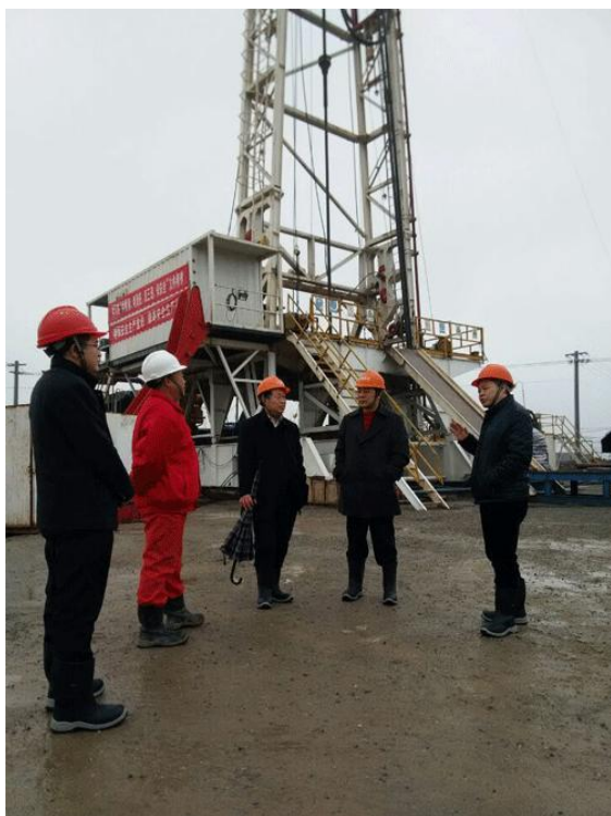
总局安全检查组到我院金坛储气库工地安全检查
