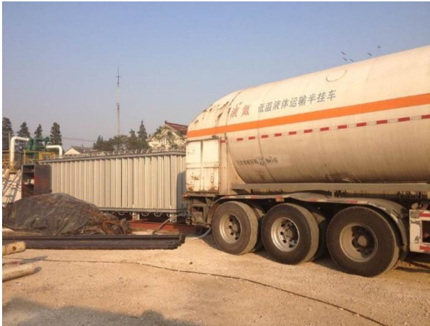
盐穴储气库气井施工
