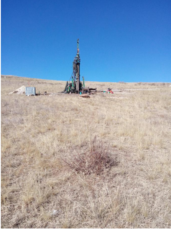
蒙古国勘查施工
