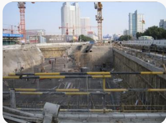
地道支护岩土工程
